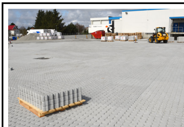
På Tine Grannes i Sola ble det i mars - april 2018 lagt et permeabelt industridekke på 4200 kvadratmeter, på et areal hvor grunnen er lite egnet for infiltrasjon.
